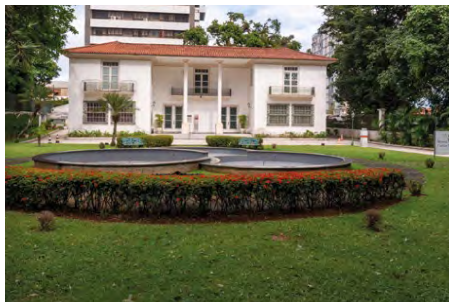
Casarão em estilo colonial que serviu de moradia da família Costa Pinto, construído em 1958 Colonial-style house that served as the home of the Costa Pinto family, built in 1958
