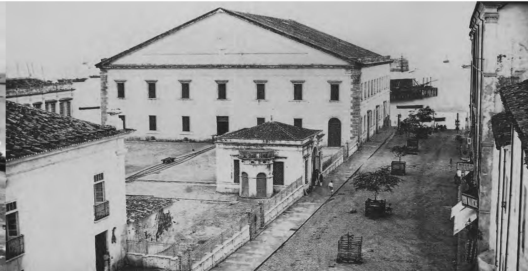
A Casa da Alfândega recém construída, em 1860, e inaugurada no ano seguinte / Casa da Alfândega, newly built in 1860 and inaugurated the following year
